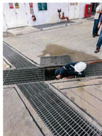
ภาพที่ 2.2-19 รางระบายน้ำฝนเชื่อมต่อกับระบบระบายน้ำฝน ของสวนอุตสาหกรรมบางกะดี
