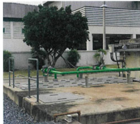
ภาพที่ 2.2-4 บ่อแยกน้ำ-น้ำมัน
