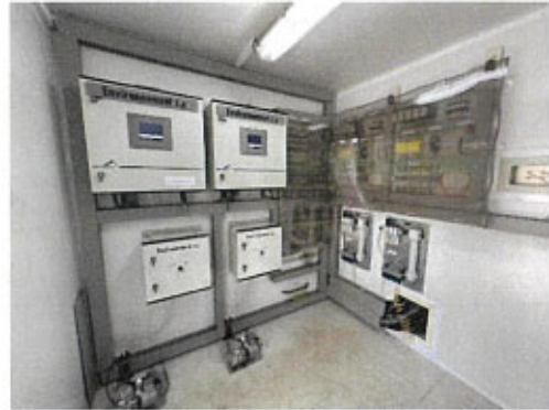
ภาพที่ 2.2-2 เครื่องตรวจวัดคุณภาพอากาศ แบบต่อเนื่อง (CEMS)
