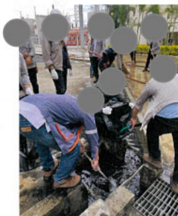
ภาพที่ 2.2-20 การขุดลอกตะกอน
